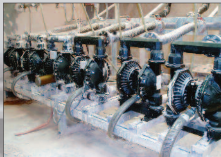
Bomba de 3" montada sobre chasis para transferir barbotina en industria cerámica.
